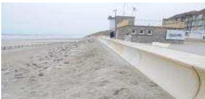
Avec sa forme creusée, le mur de 60 mètres de long empêche le sable de passer sur la digue.
